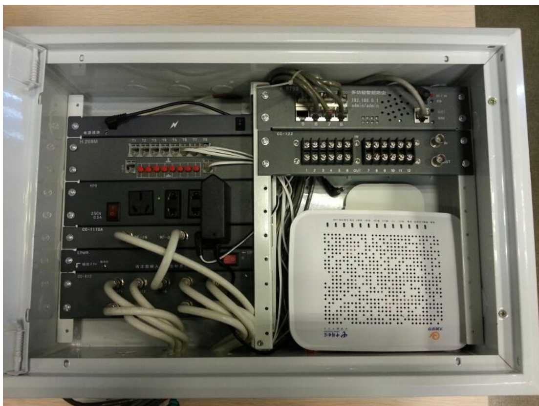
图 2 弱电箱内部示意图
